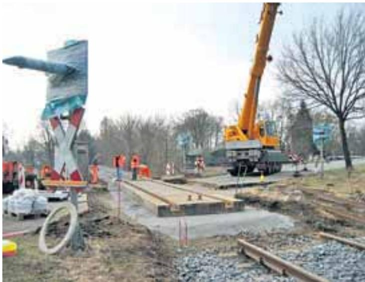
Blick auf den Bahnübergang in Heudorf: Betonblöcke mit eingelassenen Schienen ersetzen dort die alten Schwellen aus morschem Holz.
